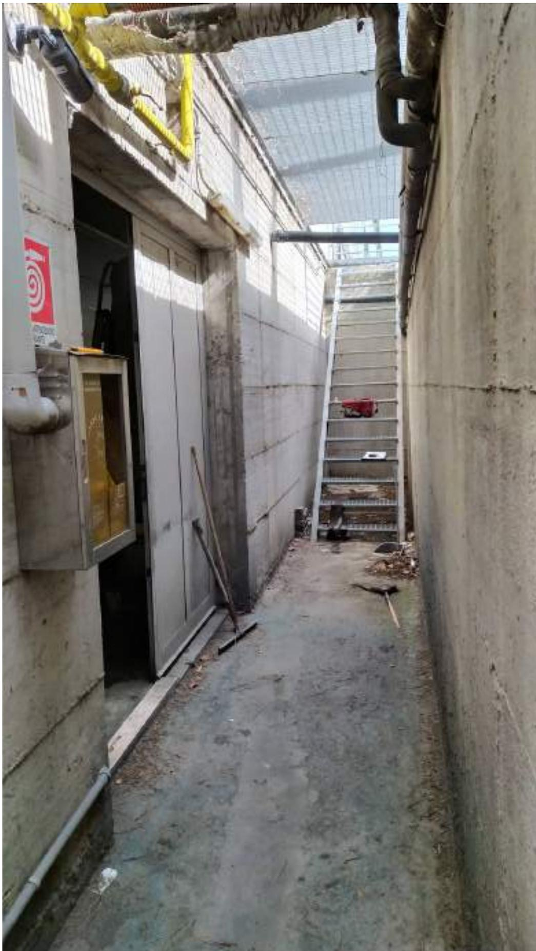
FOTO 17 Scannafosso con scala accesso esterna al piano terra
